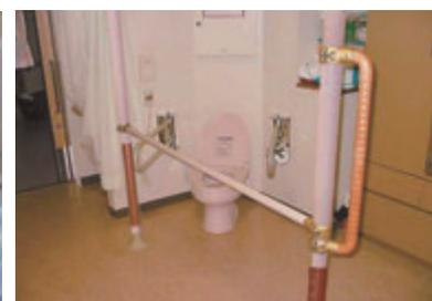
車椅子の介助スペース確保などの空間設計から広いトイレにH型と円型手すり・ウェーブ型手すりを設置しています。円型手すりの上にはクッションカバーを取り付けており、寄りかかりによる立位保持もできます。
