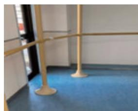
階段の踊り場で手すりが途切れており、横手すりを連結して手すり動線を繋いでいます。
